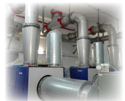
Система водоочистки в г. Вена, Австрия
